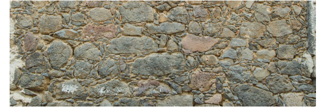
Muratura ad opera incerta in trovanti di basalto
