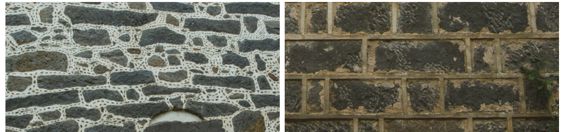
Murature in conci di basalto e trachite a vista con giunti sottili in malta di calce e scaglie lapidee.
