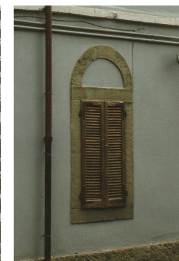
Con sistema di scarico a tutto sesto
