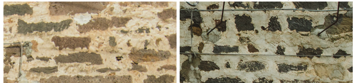
Murature in conci di basalto e trachite a vista con giunti larghi in malta di calce e scaglie lapidee.
