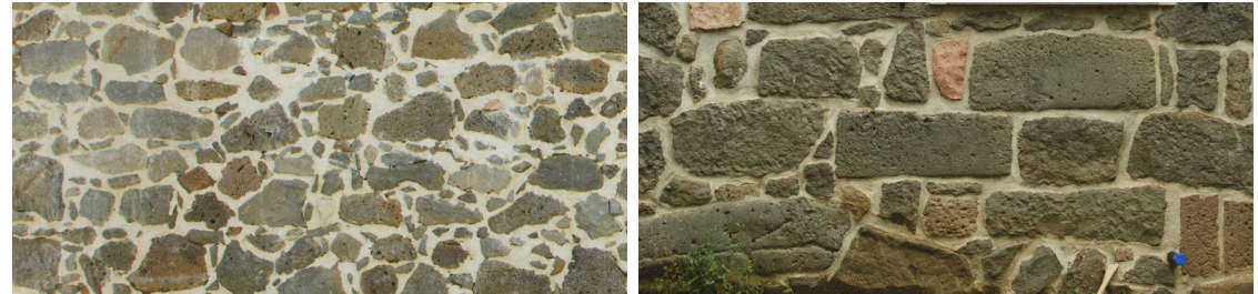
Murature in conci di basalto e trachite a vista con piccola stilatura dei giunti in malta di calce.
