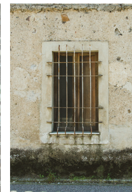
Con finitura ad intonaco
