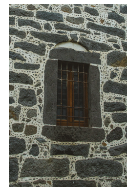
Con sistema di scarico ad arco ribassato
