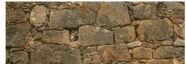
Muratura a corsi sub-orizzontali in bozze di basalto
