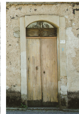
Con finitura ad intonaco
