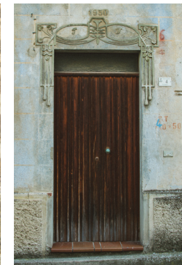
Con finitura ad intonaco
